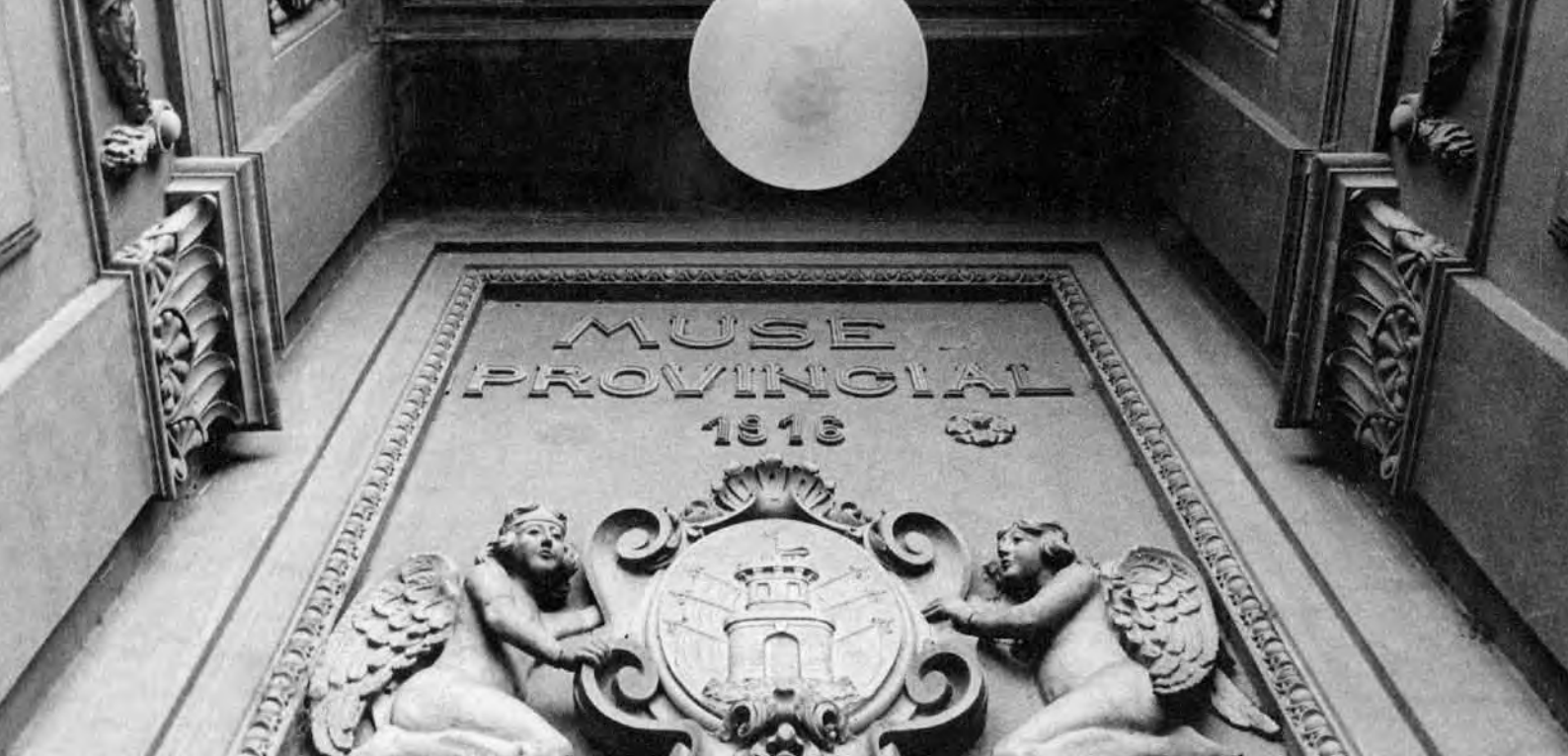
Museo Caraffa. Detalle de fachada del edificio concluido en 1916
